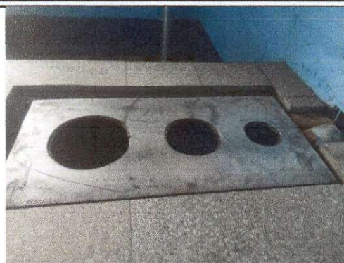
Foto 2: Sustitución de plancha de metal 3 hornillas
