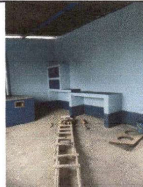
Foto 2: pintura en muros interiores y exteriores aulas y cocina
