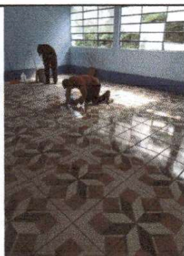
Foto 3: Sustitución de piso torta de cemento por piso cerámico
