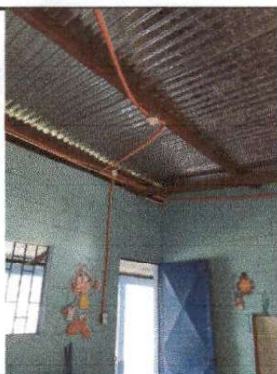
Foto 3: Mejoramiento de sistema eléctrico en aulas modulo 2
