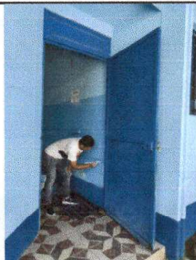
Foto1: Pintura en muros interiores y exteriores en aulas escolares
