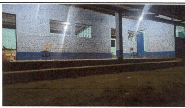
Foto 4: Mejoramiento de sistema eléctrico modulo 2 establecimiento
