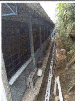
Foto 5: Reparación muro perimetral de block
